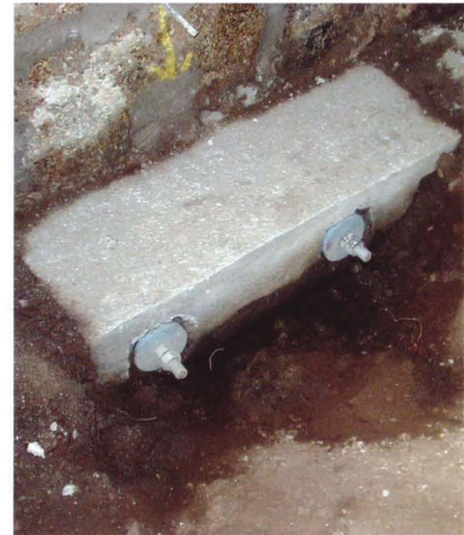
Aspecto final de maciço de encabeçamento
