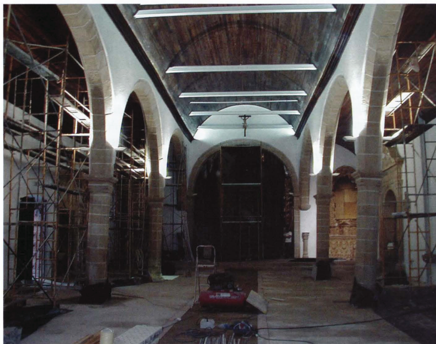
Aspecto da obra, na fase final
